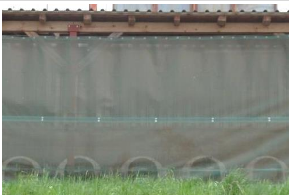
Obr. 13. Protiprůvanové sítě omezují nadměrné proudění vzduchu do VIB
