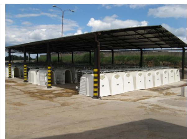
Obr. 7. Vysoká střecha (nad 450 cm) brání přehřátí VIB v odpoledních hodinách
