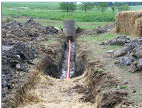
Obr. 28: Příklad biofiltru se slámovou náplní (foto M. Nechvátal)
