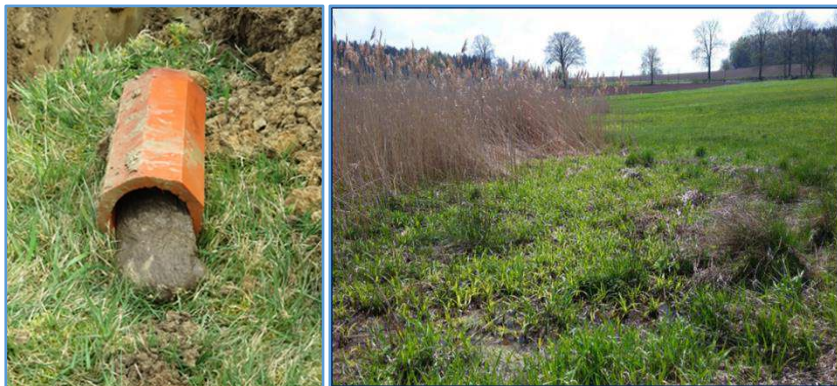
Obr. 43: Příklady stárnutí drenáže. Vlevo zarůstání drenážky kořeny, vpravo mokřad vniklý dlouhodobou poruchou drénu. (foto A. Zajíček)
