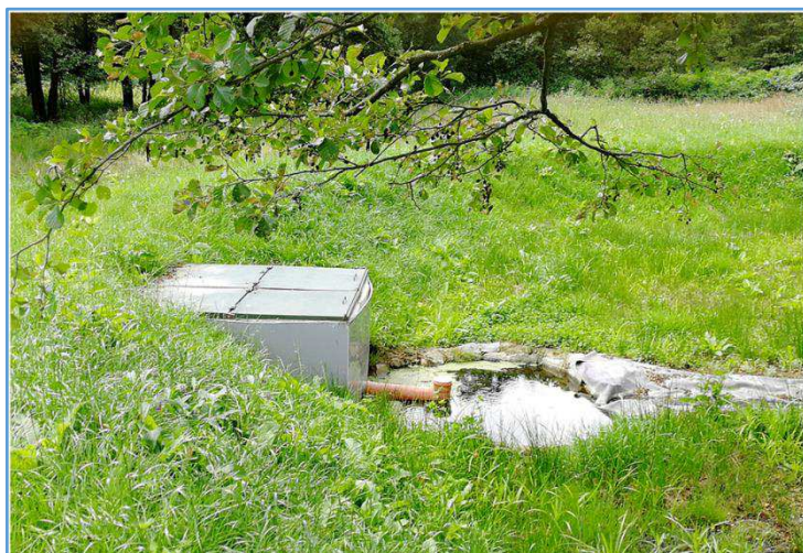
Obr 34: Experimentální Umělý mokřad Velký Rybník – předřazený objekt (VÚMOP, v.v.i, foto A. Zajíček)
