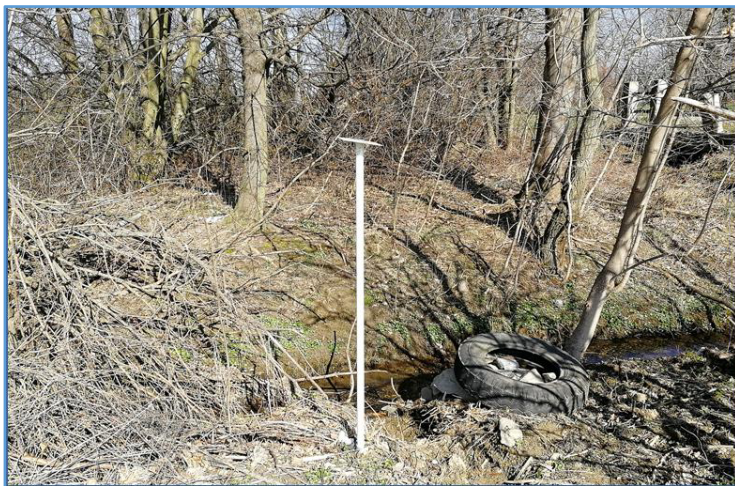
Obr. 12: Terénní průzkum – identifikace drenážní výustě a zhodnocení jejího stavu (pilotní lokalita Žejbro, foto A. Zajíček)
