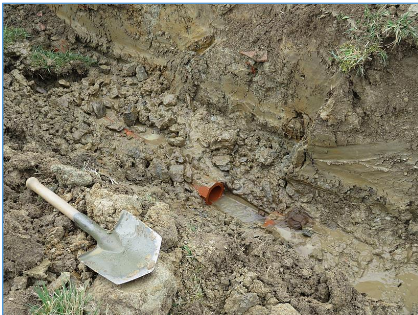
Obr. 41: Příklad odkrytí drénu (lokalita Dehtáře (foto A. Zajíček))
