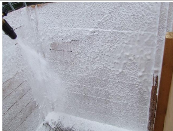
Obr. 17. Pěnová dezinfekce umožňuje vizuální kontrolu nanesení a překrytí čistěného místa
