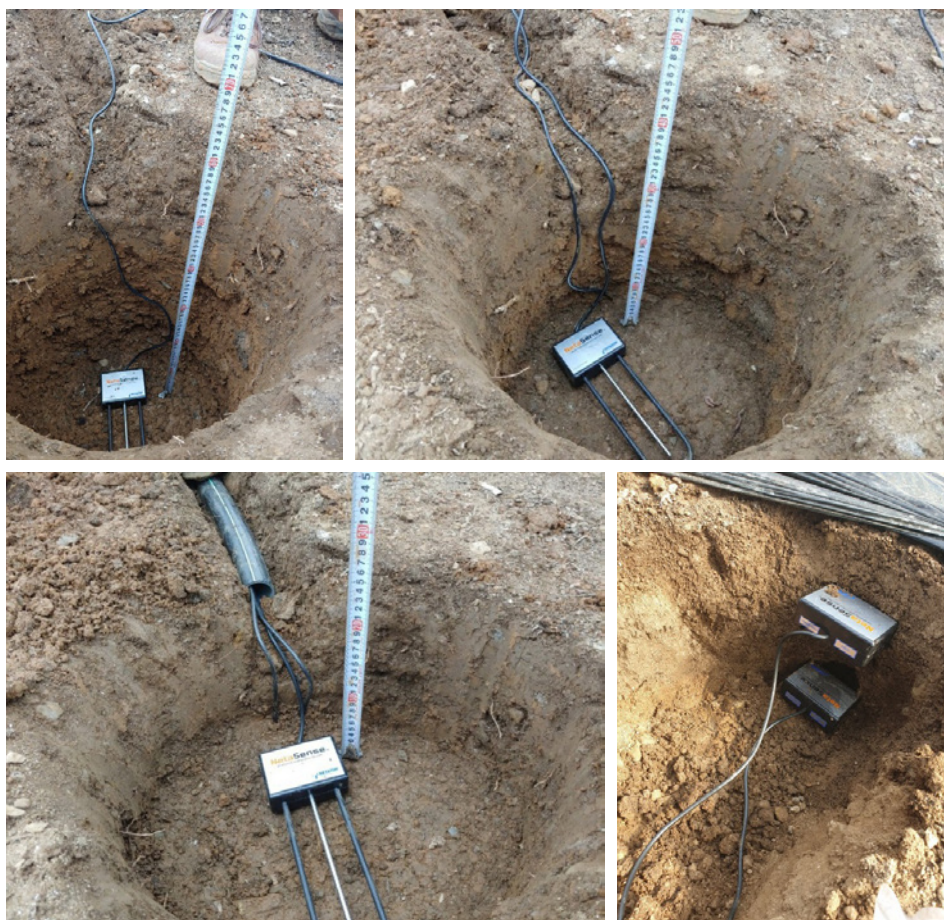
Obrázek 5. Postupná instalace tří snímačů půdní vlhkosti Netasense do vykopané jámy nad sebou a dvou snímačů do boční stěny výkopu (vpravo dole)
