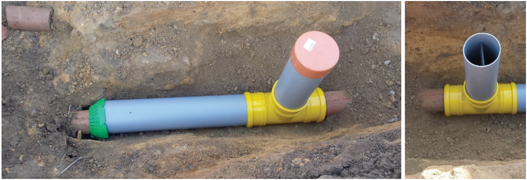
Obr. 2.2.4 Konstruční provedení a realizace prefabrikovaných prvků PRO podle technického návrhu VÚMOP v.v.i. (foto: Z. Kulhavý)
