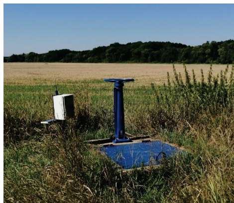
Obr. 2.5.11 Regulační/rozdělovací šachtice RŠ1
