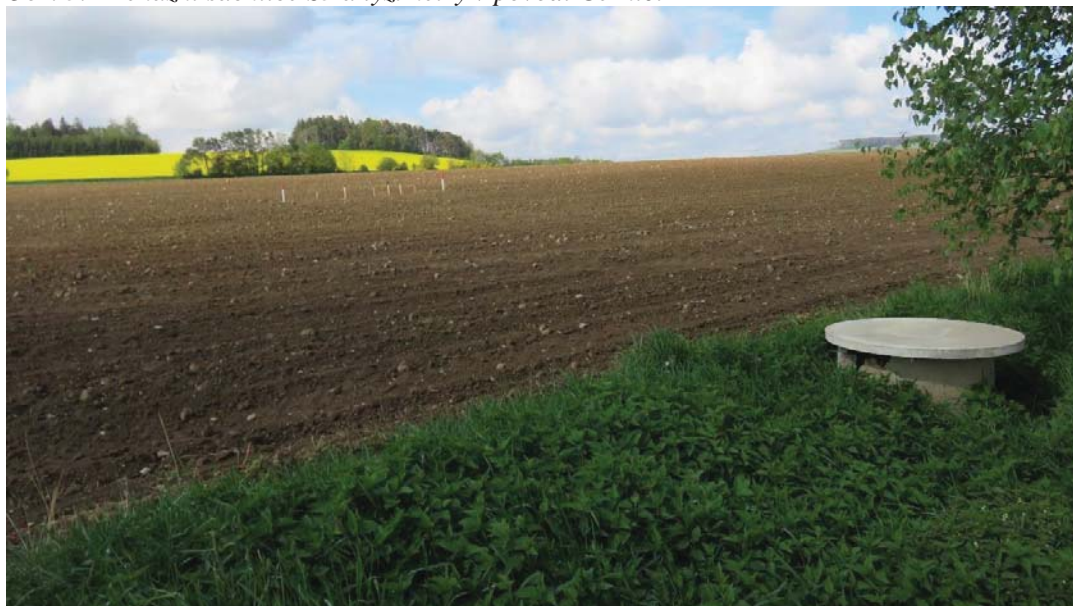
Obr. 5. Drenážní šachtice Š5 a lyzimetry v povodí Černičí
