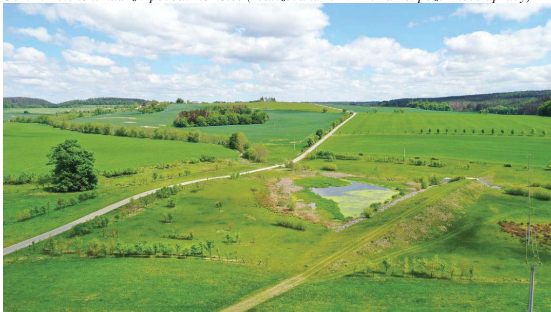
Obr. 1. Retenční nádrž v povodí Němčice (realizovaná r. 2012 v rámci pozemkové úpravy)
