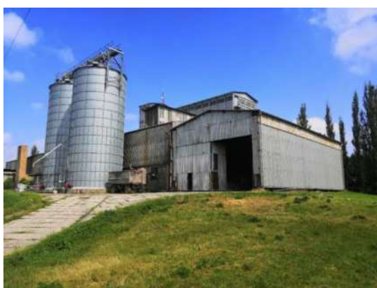
Obr. 4.17: Budova posklizňové linky (sila) a vlastní silo, na kterém je umístěna základnová stanice sítě LoRaWAN.
