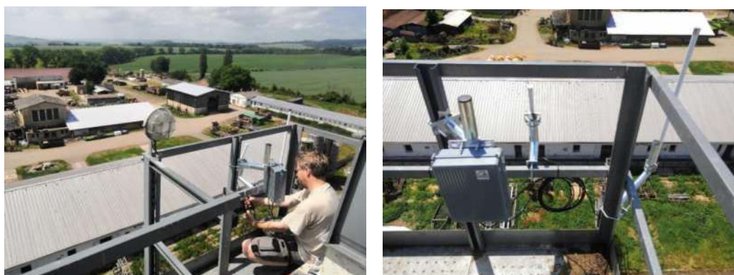
Obr. 4.18: Instalace brány sítě LoRaWAN a příslušných antén na budově sila ve středisku Knínice (vlevo brána sítě LoRaWAN, uprostřed výložník s LTE anténou, vpravo výložník s anténou sítě LoRaWAN).
