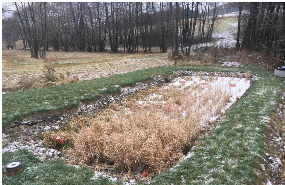
Obr. 14. Mořadní pole M1; patrná výrazně vyšší biomasa vegetace na přítoku do mokřadu ve srovnání s odtokovou zónou; Foto: J. Vymazal
