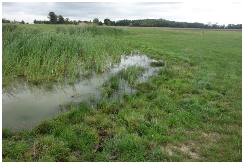
Obr. 2. Příklad realizace mokřadu na stavbě odvodnění. Svodný drén v místě mokřadu byl řízeně přerušen; vtok vody z mokřadu zpět do drénu umožněn bezpečnostním přelivem (bílá vtoková roura); Foto: P. Fučík
