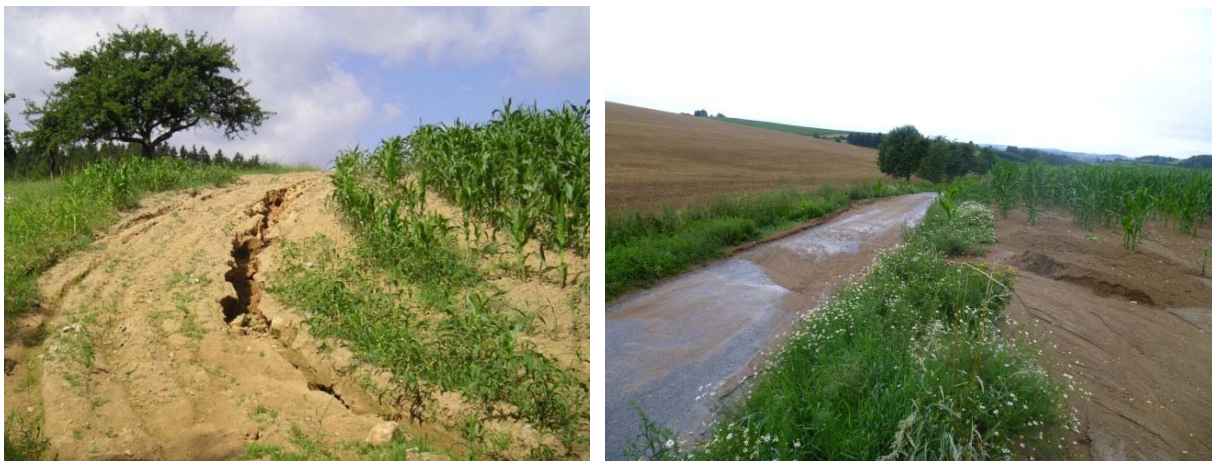
Obrázek 3. Projevy erozních událostí (foto VÚMOP, v.v.i)
