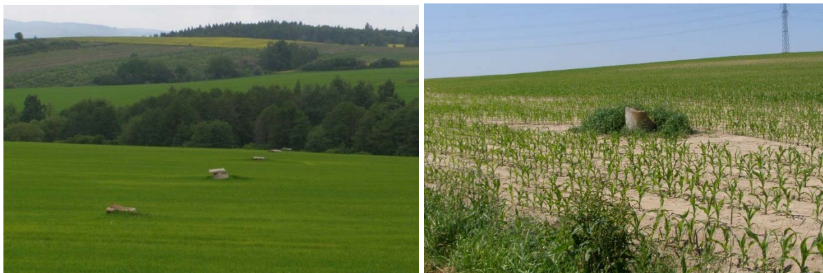
Obrázek 7. Drenážní šachtice na zemědělském pozemku (foto VÚMOP, v.v.i.)
