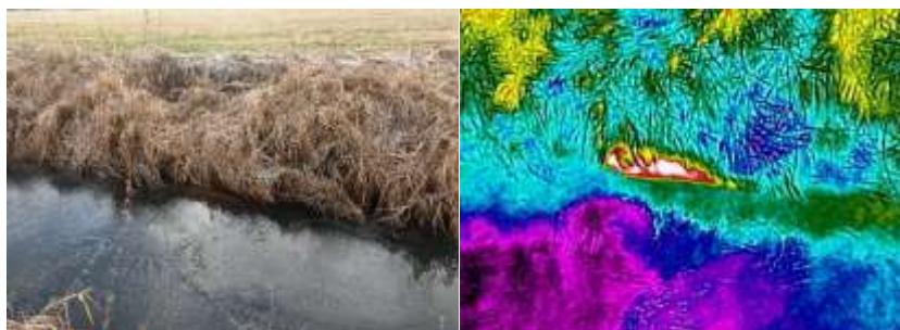
Obr. 28: Fotografie a termogram drenážní výusti – Sobiňov.
