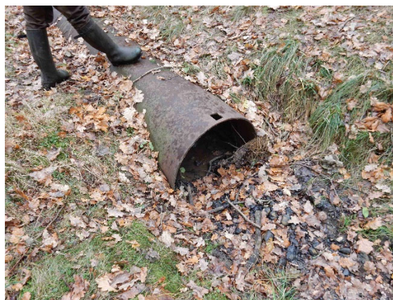
Obrázek 10.4.8: Trubní propustek / hospodářský propustek / dočasný propustek na lesní cestě, resp. na samostatném sjezdu z ocelových trub spirálně svařených, bez čela Pozn. Otvor v troubě slouží k manipulaci a transportu trouby při použití v dočasných trubních propustcích! - autor: Karel Zlatuška
