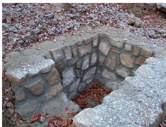
Obrázek 10.4.10: Vtoková jímka trubního propustku na lesní cestě ze zdiva z lomového kamene na maltu cementovou s vyspárováním (bez římsy), s jednostranným přítokem - autor: Karel Zlatuška
