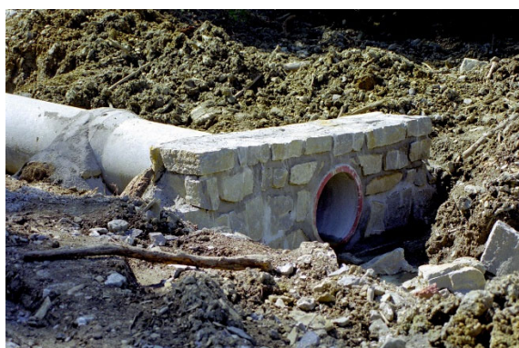
Obrázek 10.4.3 Trubní propustek na lesní cestě ze ŽB trub, přímé vtokové čelo ze zdiva z lomového kamene na maltu cementovou s vyspárováním - autor: Karel Zlatuška
