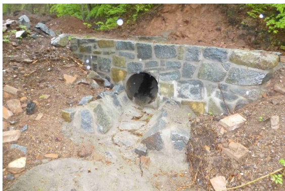
Obrázek 10.4.13 Trubní propustek na lesní cestě z ocelové trouby, přímé výtokové čelo ze zdiva z lomového kamene na maltu cementovou s vyspárováním, spadiště z kamenné dlažby - autor: Jiří Ježek
