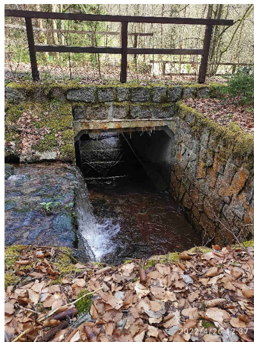
Obrázek 10.4.2: Rámový propustek - autor: Alena Tichá
