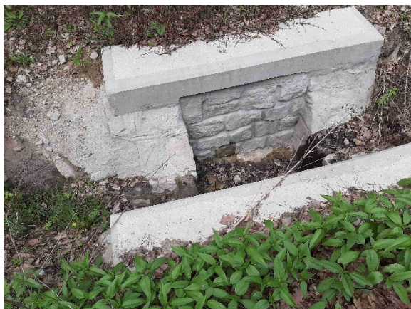
Obrázek 10.4.9: Vtoková jímka trubního propustku na lesní cestě ze zdiva z lomového kamene na maltu cementovou s vyspárováním, se ŽB římsou, s oboustranným přítokem - autor: Karel Zlatuška
