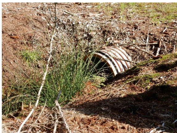
Obrázek 10.4.5: Trubní propustek na lesní cestě ze ŽB trub, přímé vtokové čelo ze zdiva z lomového kamene na sucho do drátěných košů (gabionů) - autor: Karel Zlatuška
